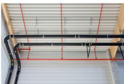
**Alle fünf Meter** : Festpunktschellen, die mit der SitaRail Montageschiene verschraubt werden.
