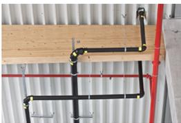
**Drunter und drüber ohne Kollisionen** – sichergestellt durch sorgfältige CAD-Planung, abgehängt mit Traversen, die die Last verteilen.
