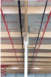
**Platzsparend parallel zur Hallendecke** verlaufen die schwarzen Rohre der Druckströmungsentwässerung und das rote Rohrsystem der Sprinkleranlage.
