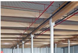
**Extreme Spannweiten** forderten eine Langstreckenplanung von Haupt- und Notentwässerung in Harmonie mit der Sprinkleranlage.
